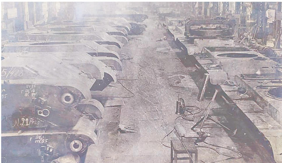
Сборка и сварка корпусов танка Т-44.
